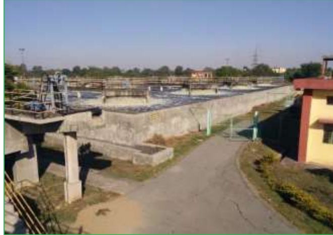
Bilaspur (Chilhathi) 17 MLD
